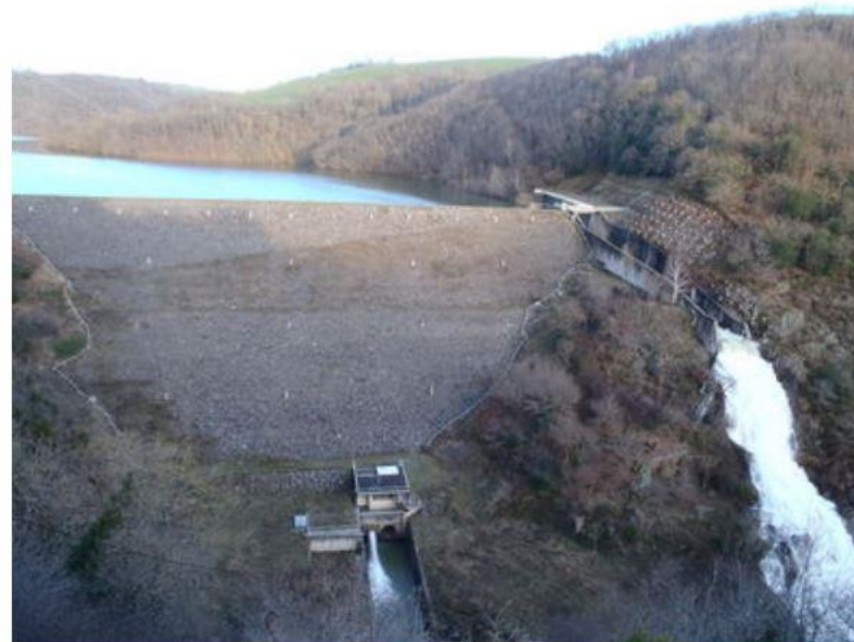
Saint Géraud : Barrage en enrochements à noyau d'argile.
